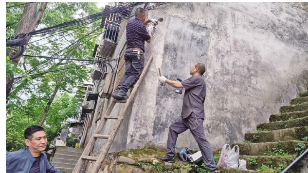
路灯管理所工作人员正在安装路灯
