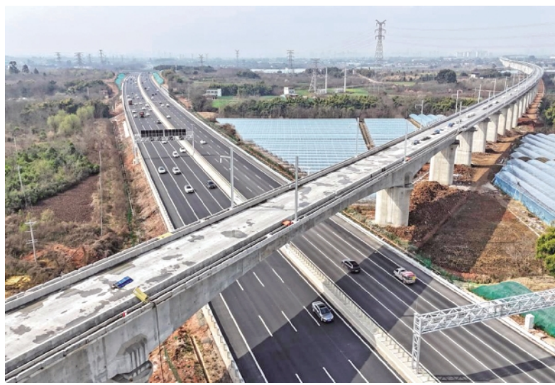
2月10日,成渝中线高铁四川段桥梁建设全部完成。这是当日在成都市拍摄的成渝中线高铁最长桥梁龙泉特大桥跨泸蓉高速公路(无人机照片)。新华社记者 王曦 摄
