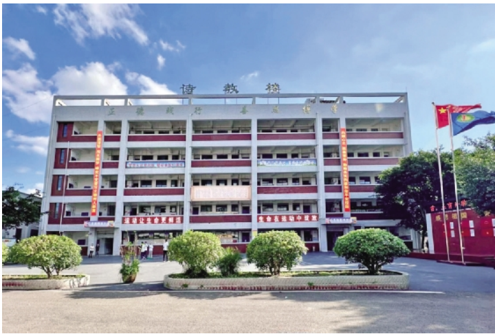
汪洋镇初级中学校教学大楼。
